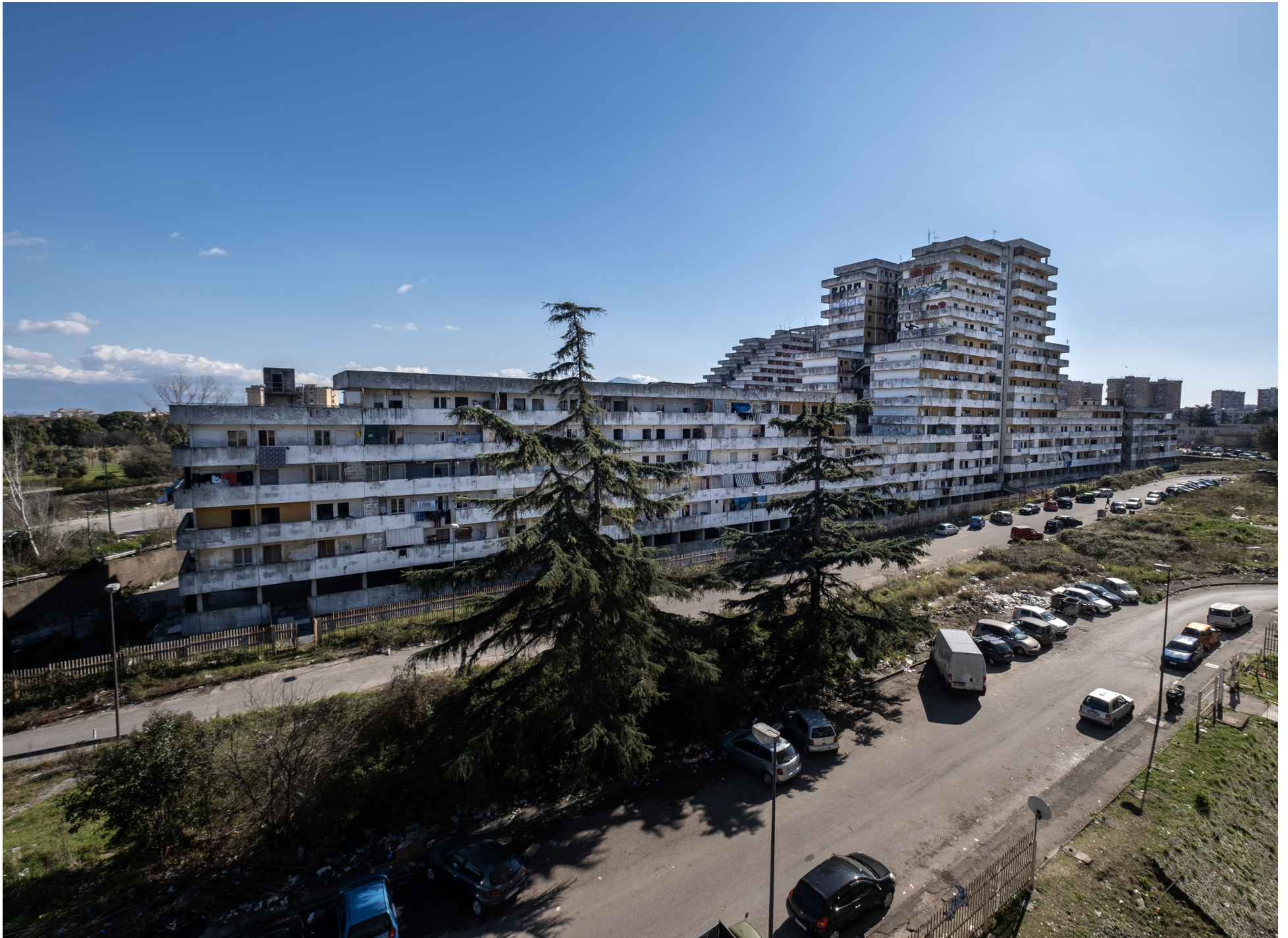
Een van de nog overblijvende sociale woonblokken in Scampia, die Le Vele (De zeilen) worden genoemd. © Federico Quagliuolo
